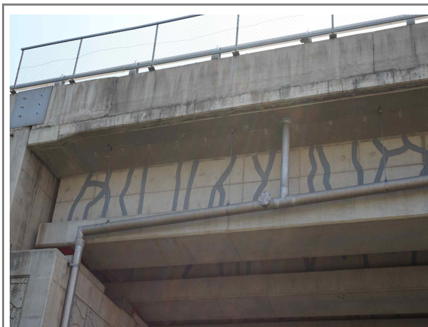
균열 (0.3mm미만) 보수 완료
