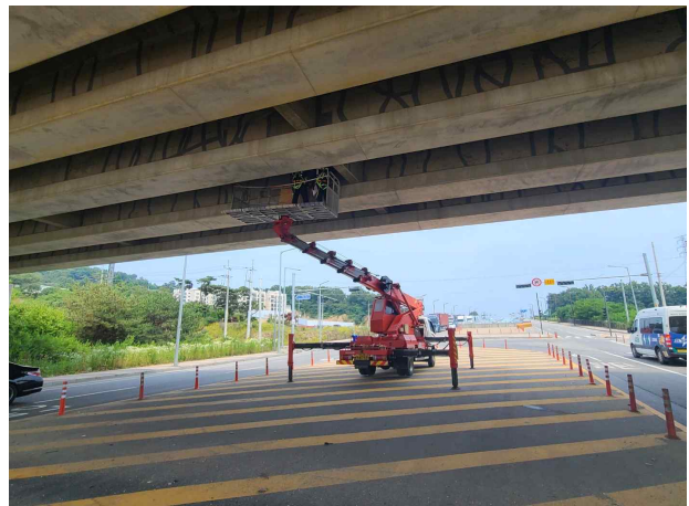
고소작업차를 이용한 외관조사 현황
